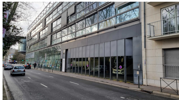
Porte d'accès à l'aire de livraison
